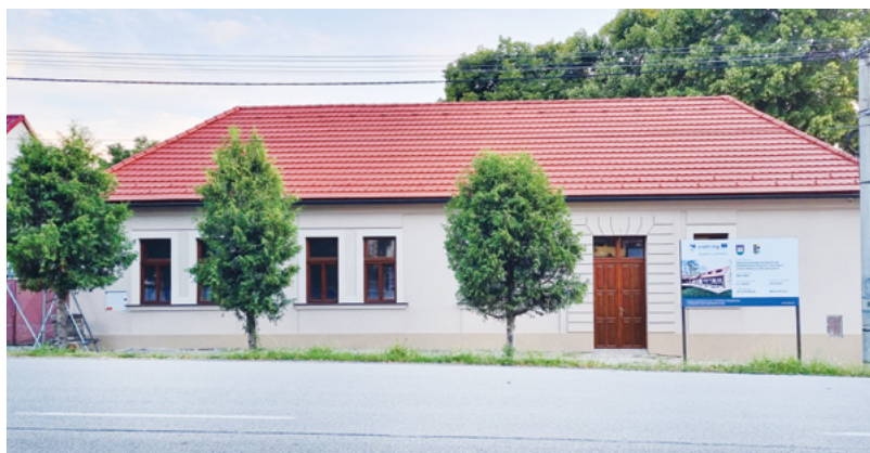
► Aktuálny stav po renovácii
