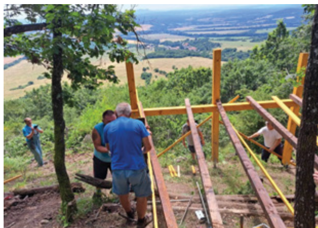
► Výstavba vyhliadky pod Vínny vrchom (522 m). Foto: Viktória Hikkerová
