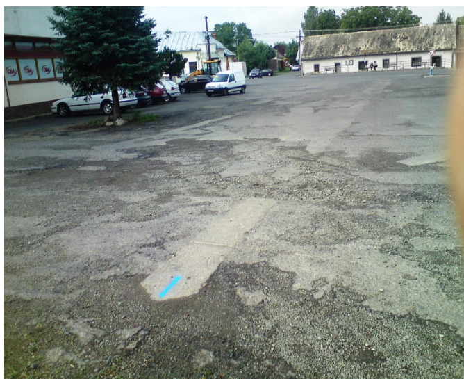
Časť centra obce pred rekonštrukciou
