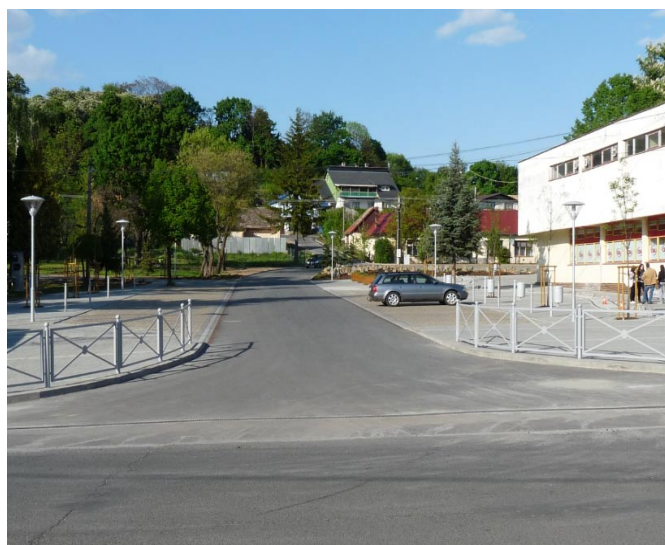
Časť centra obce po rekonštrukcii
