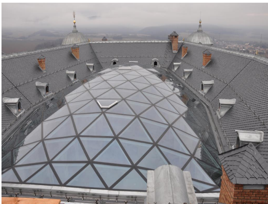
Zrekonštruovaná strecha na Haličskom zámku
