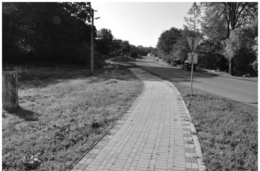
Chodník do cintorína pred dokončením
