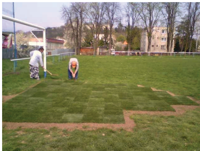
Zakladanie trávového koberca
